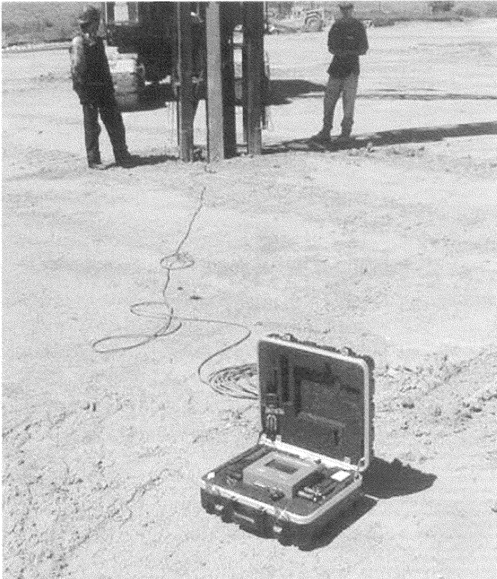
Bild 5: Rammfähle: PDA mit Telefonverbindung im Einsatz
